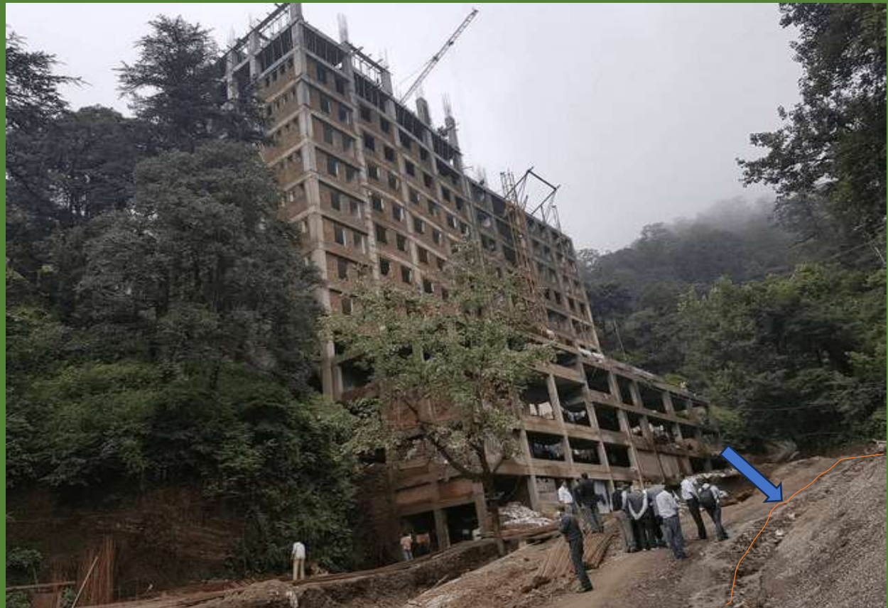
चित्र 2: नए ओपीडी भवन निर्माण के दौरान प्रस्तावित भूमि
